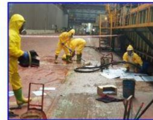
[유해화학물질 누출 및 방제작업]
